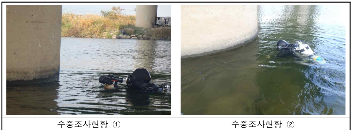
<사진 1.1> 수중조사 현황
